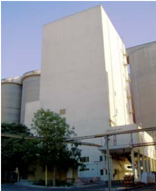
Bulguranlage in den Emiraten
