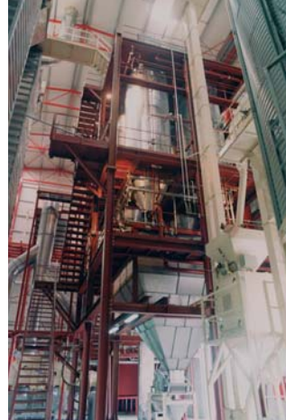
Komplette Parboilinganlage in Griechenland
